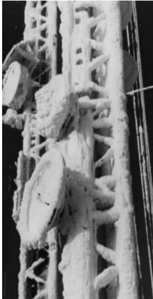
Σχήμα 14: Συσσώρευση επίταγους στον πύργο (Sundin and Makkonen 1998).
